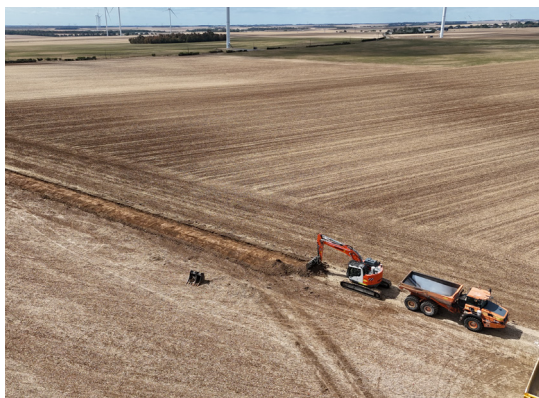
Décapage de terre végétale pour créer un chemin d'accès aux éoliennes
