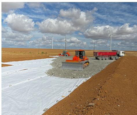
Réalisation de la plateforme de la base vie
