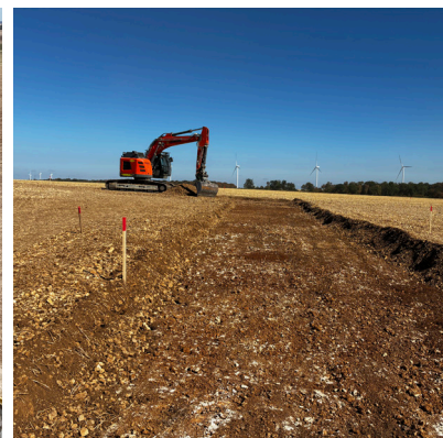
Décapage de terre végétale pour créer un chemin d'accès aux éoliennes
